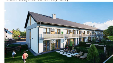
Widok budynku od strony ogródków
