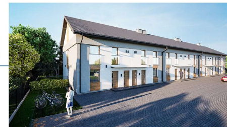
Widok budynku od strony ulicy
