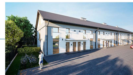
Widok budynku od strony ulicy
